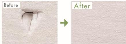
破損した石膏ボードをパテで埋め、壁紙を貼ることでほぼ元どおりの状態に復元。
